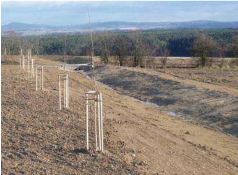
Zasakovací průleh s propustkem
